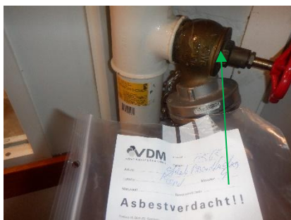
Aanzicht koord, monster 4 en koord, afsluiter, brandblusleiding kelder t/m 8e verdieping
