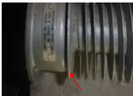
Aanzicht pakking, radiator tussen flens liftkamer 1
