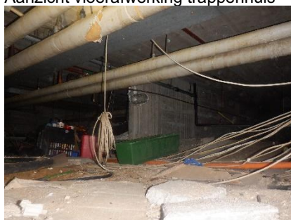
Aanzicht leidingisolatie en riolering aanwezig in kruipruimte
