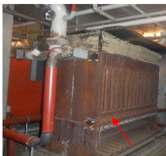
Aanzicht ketel Remeha gas 6 bj. 1968, verwerkt in ketel 1 cv ruimte
