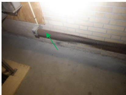
Aanzicht spiraalkachel REF 220 volt 1500 watt bj. 1987, verwerkt in spiraalkachel liftkamer 2
