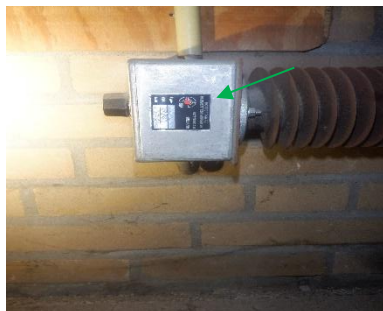
Aanzicht spiraalkachel REF 220 volt 1500 watt bj. 1987, verwerkt in spiraalkachel liftkamer 2
