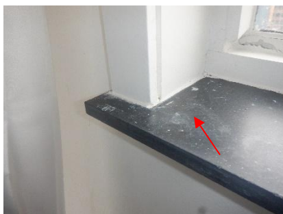
Aanzicht vensterbank, ingemetseld begane grond t/m 8e verdieping
