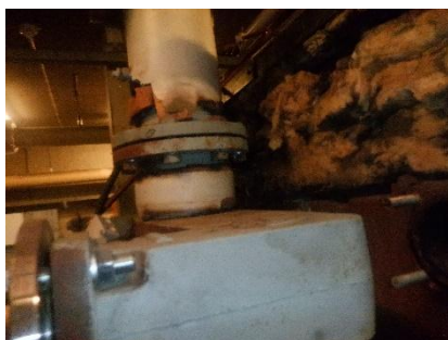
Aanzicht pakking, tussen flensen en afsluiters kelder en cv ruimte
