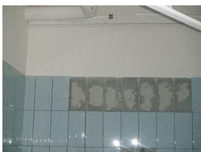
Aanzicht lijm, monster 5 t/m 10 en achter blauwe, groene en witte wandtegels kelder t/m 8e verdieping
