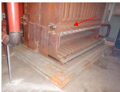
Aanzicht ketel Remeha gas 6 bj. 1968, verwerkt in ketel 1 cv ruimte
