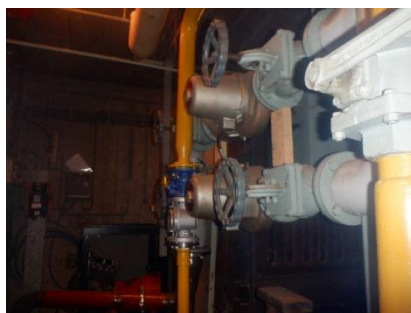
Aanzicht pakking, tussen flensen en afsluiters kelder en cv ruimte
