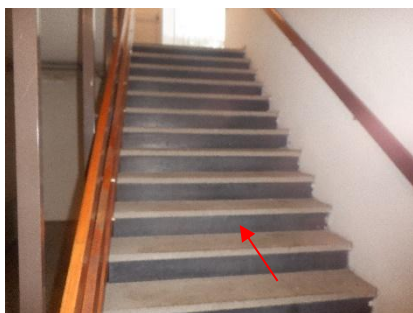
Aanzicht plaatmateriaal, stootbord trappenhuis kelder richting begane grond
