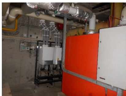
Aanzicht ketel Viessmann Paromat R. 13152-56 bj. 1980, verwerkt in ketel 2 cv ruimte
