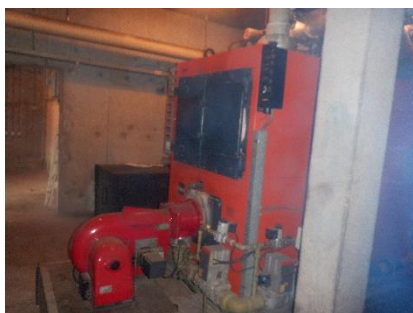
Aanzicht ketel Viessmann Paromat R. 13152-56 bj. 1980, verwerkt in ketel 2 cv ruimte
